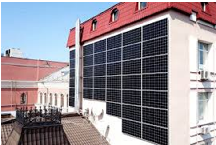
Рисунок 4.21 - Приклад використання фасадних поверхонь будівлі для СЕС
