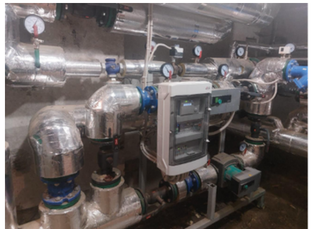
Рис. 9 Погодне регулювання, теплоізоляція трубопроводів та енергомоніторинг – як перший та найбільш ефективний крок до енергоефективності.
